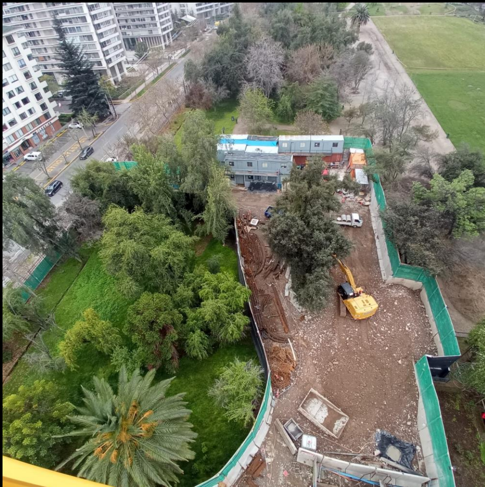
Pique de construcción Estación 16 – Línea 7
