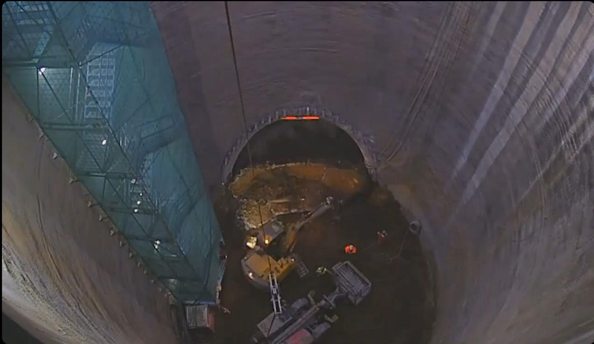
Construcción de Extensión de Línea 2 durante años 2020
